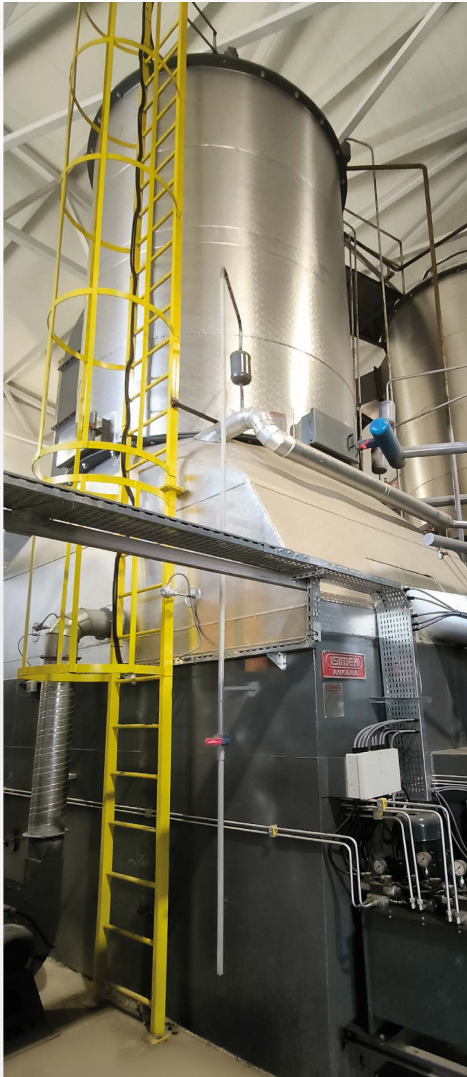
2024 - 2025 / Ukrayna Biyokütle Yakıtlı Kızgın Yağ Kazanı (Kapasite: 3.000.000 kcal/h-6 Bar)
